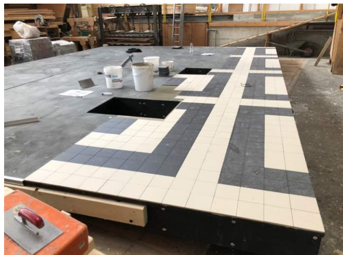
Vorfertigung der Elemente
