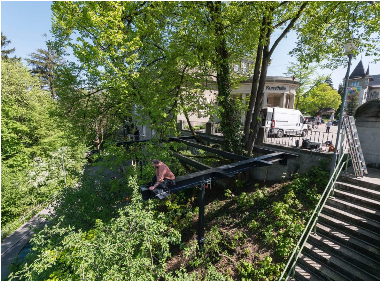
Bau der Plattform
