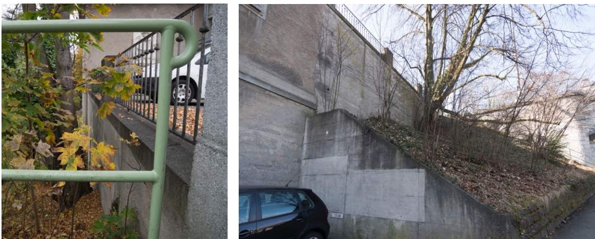
Hang über dem die Bar installiert wurde
